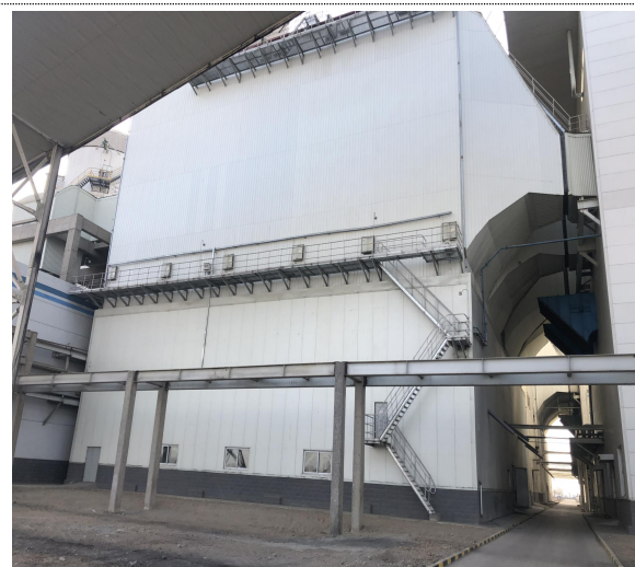
双室五电场静电除尘器现场照片
