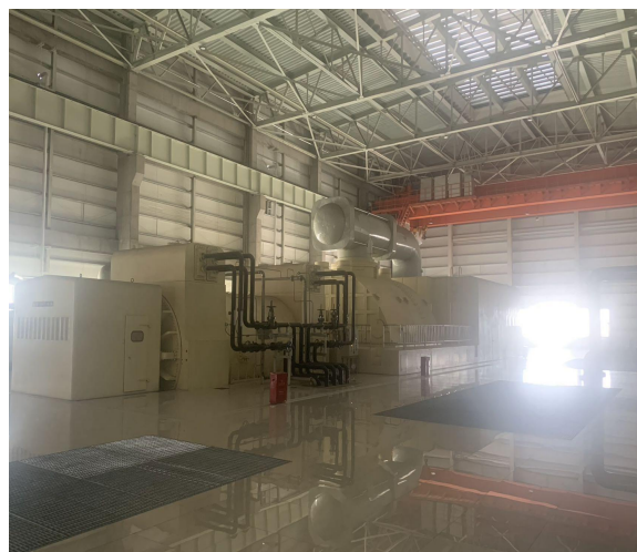
#2 机组 350 兆瓦发电机组
