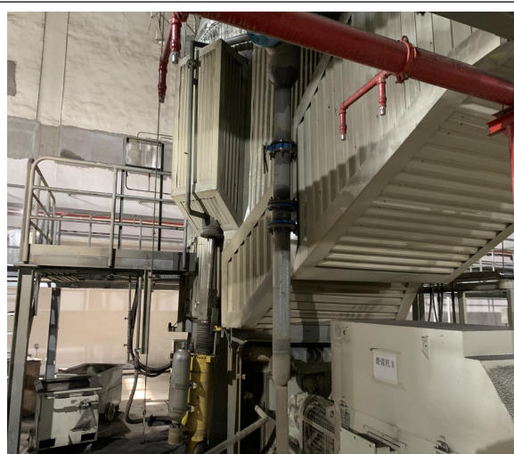
SCR 选择性催化剂还原法脱硝设备
