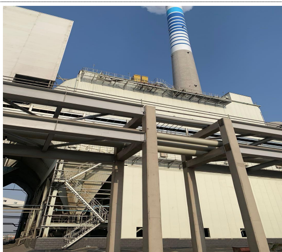
双室五电场静电除尘器现场照片
