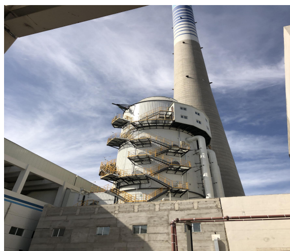
石膏法脱硫塔现场照片
